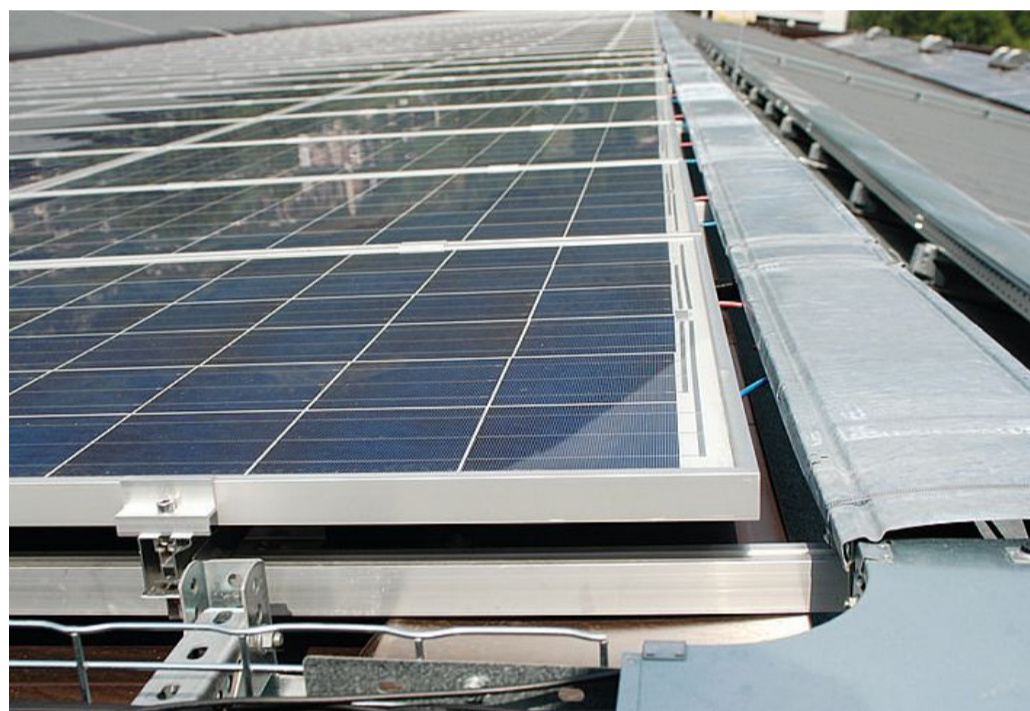
Impianti fotovoltaici saranno installati in 20 istituti scolastici della città
